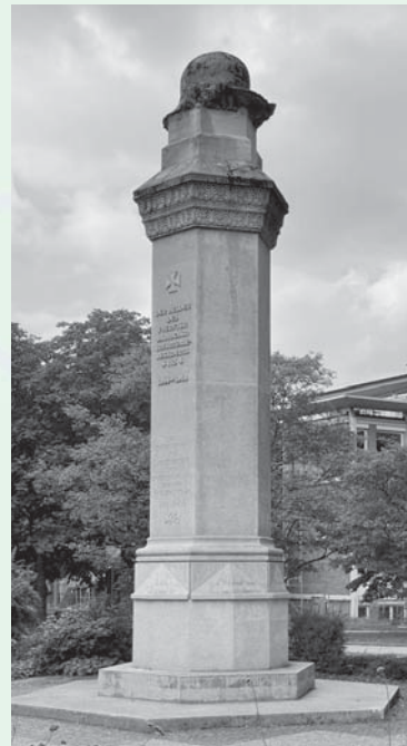
»Den Helden des 113. Badischen Infanterieregiments« gewidmet: der 9 m hohe »Hutständer« aus Beton von Carl Anton Meckel, 1925, Nordrand des Stadtgartens
